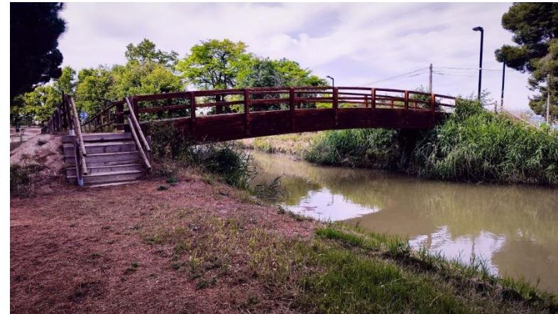
**TIPO:** pasarela horizontal apoyada sobre muros de hormigón.
